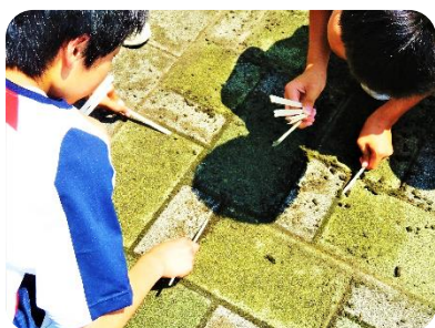
根気のあるブロック目地の土を掻き出す作業
