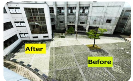
高圧洗浄作業前と後を比較すると一目瞭然です
