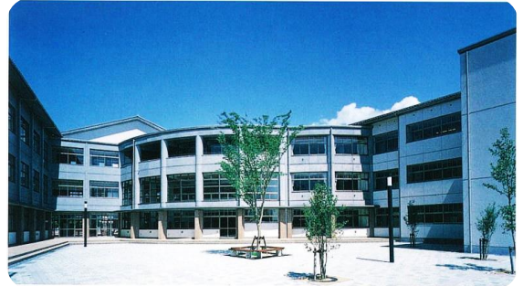
新校舎完成当時の中庭の様子（平成9年6月）
